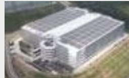
太陽光パネル
