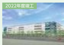
東京レールゲート EAST (注4)
