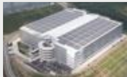
太陽光パネル
