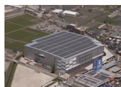
太陽光パネル
