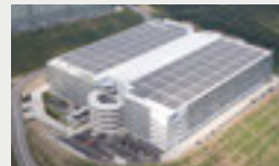
太陽光パネル
