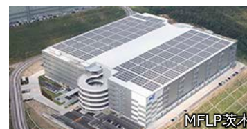
太陽光パネル
