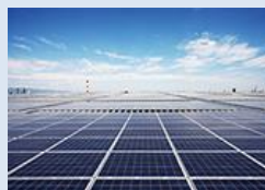
太陽光パネル
