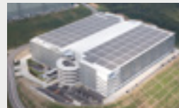
太陽光パネル
