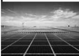
■ 太陽光パネル
