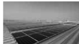
■ 太陽光パネルの設置
