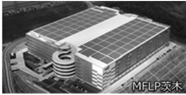
太陽光パネル
