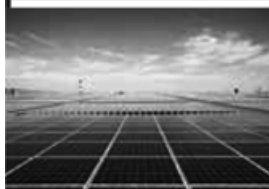
■ 太陽光パネル
