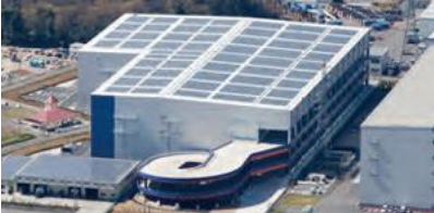
太陽光パネル
