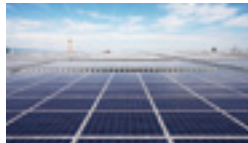
■ 太陽光パネル
