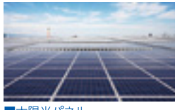
■ 太陽光パネル
