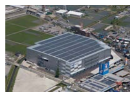
太陽光パネル
