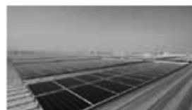
■ 太陽光パネルの設置
